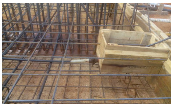
Figura 4. Desviación de la tangente del trazado con respecto al anclaje
