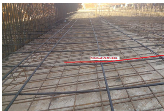
Figura 3. Trazado con falta de elementos de posicionamiento
