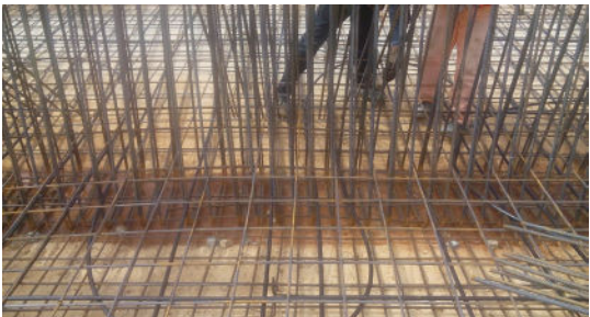
Figura 2. Desviación de una rama de un cable con bucle por presencia de armadura pasiva
