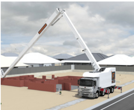
Figura 3. Imagen de Hadrian X, el robot albañil
