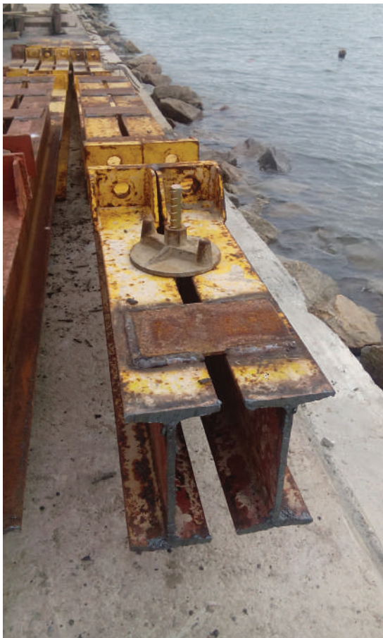
Figura 5. Ejemplo de fijación de barra roscada a superestructura.
