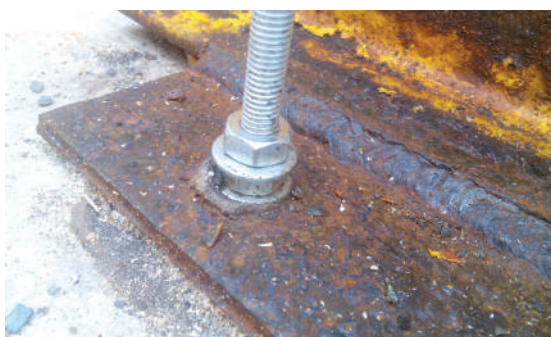
Figura 8. Ejemplo de anclaje de superestructura a un piso de hormigón
