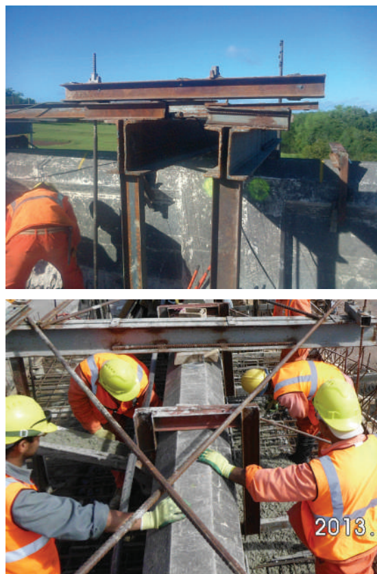
Figura 7. Sistema de superestructura con carga excéntrica
