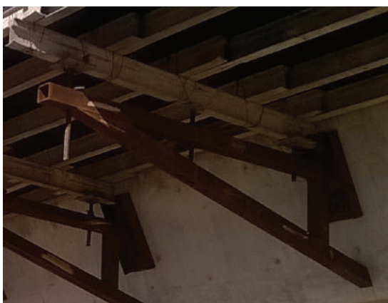
Figura 6. Estructura de encofrado en ménsula
