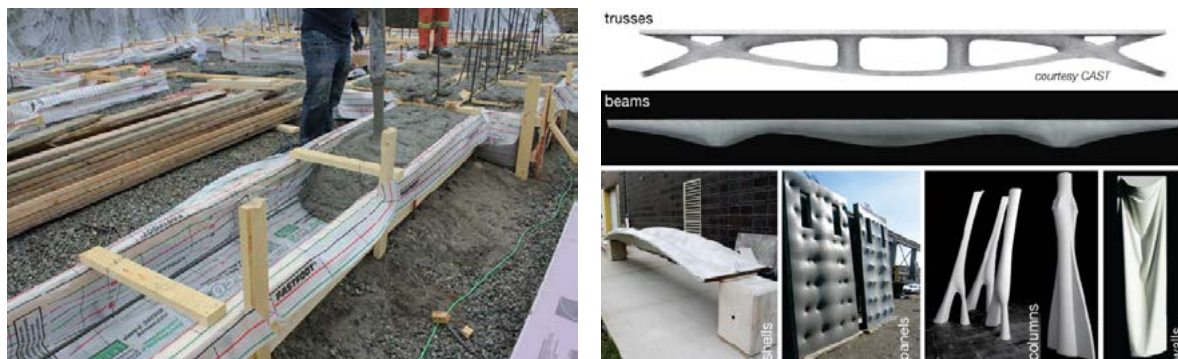
Figura 2. Izquierda: Encofrado flexible para fundación directa corrida. Derecha: Estructuras experimentales del centro C.A.S.T.
