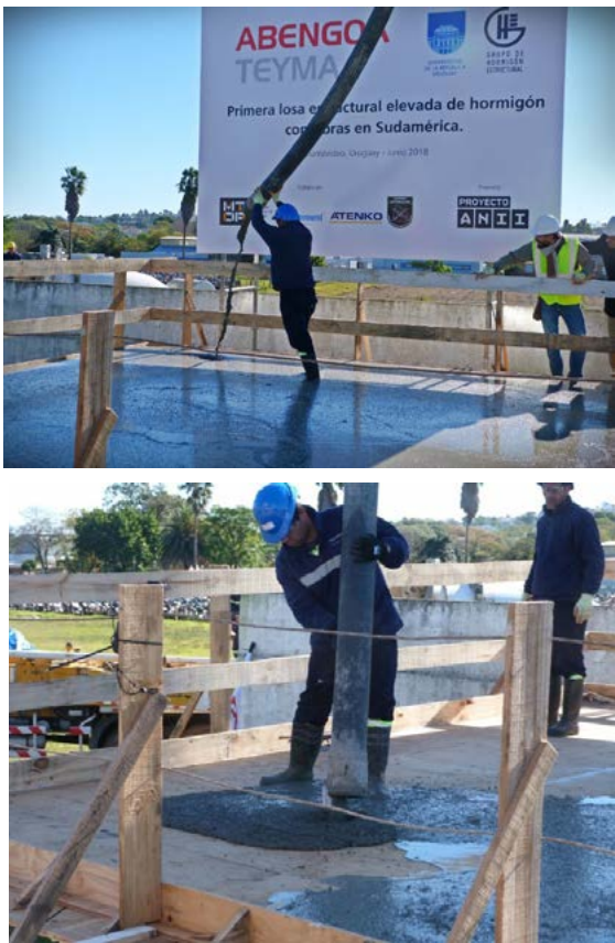
Figura 2 – Proceso de llenado de la losa de HRF
