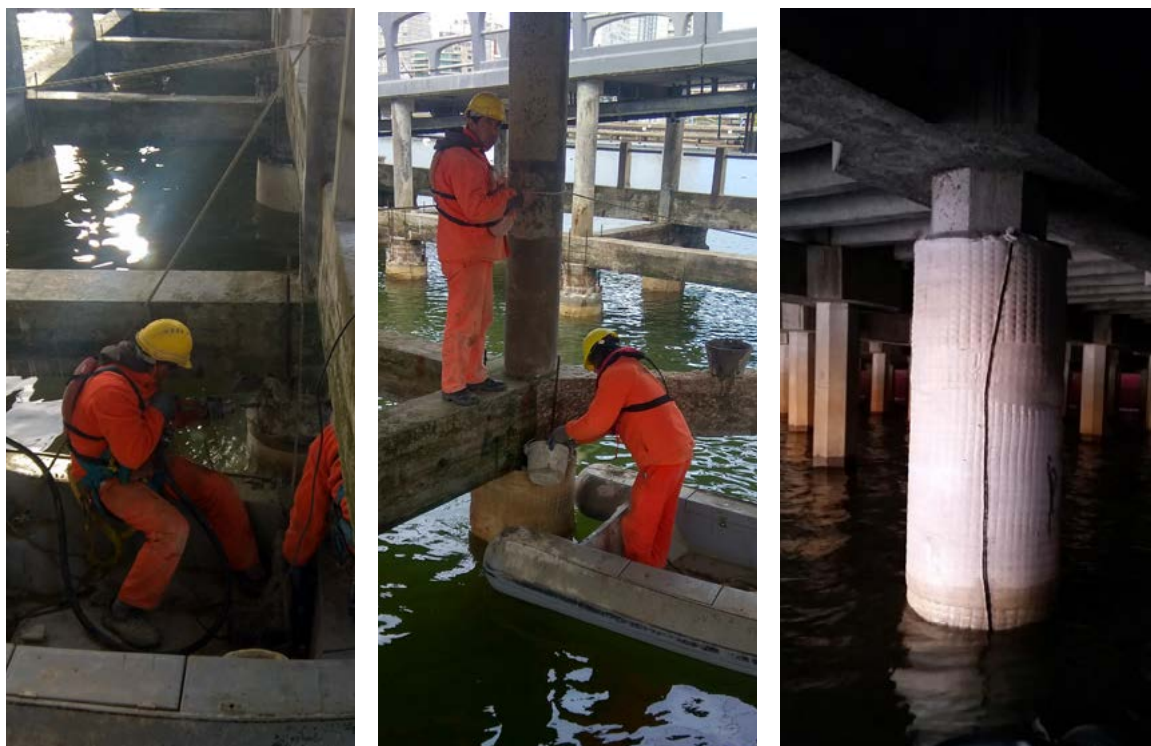
Figura 7. A la izquierda, tareas de desmoché del pilote. A la derecha, pieza terminada
