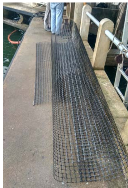
Figura 5. A la izquierda geotextil utilizado como encofrado. A la derecha geo – malla de refuerzo
